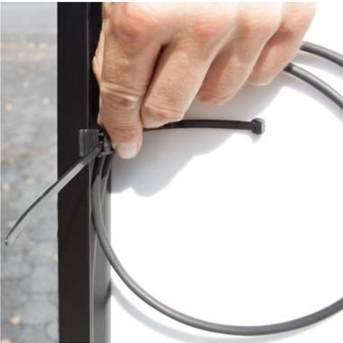
Verlegen Sie das Kabel bis zum Solarmodul und befestigen Sie es am Modulrahmen mit einem der mitgelieferten Edge-Clips unterhalb des vorgesehenen Messpunktes, damit kein Regenwasser zum FTS fließen kann.
