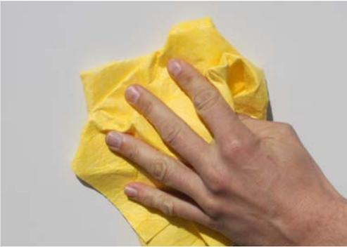
Bevor der FTS am Solarmodul angebracht werden kann, muss die hintere Modulfläche gereinigt werden. Um eine optimale Befestigung des FTS zu erreichen, muss die Fläche frei von Staub und Fett sowie trocken sein.
