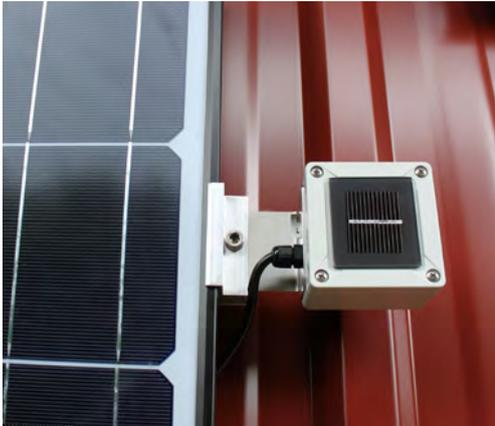
Der Spektron 320 wird mit der Halterung an das Montagegestell der PV-Anlage befestigt. Es ist darauf zu achten, dass der Sensor die gleiche Neigung und Ausrichtung wie die zu überprüfende PV-Anlage hat. Selbst geringfügige Abweichungen können zu Messfehlern führen!
