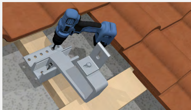
Abb. 1, Dachhaken setzen
